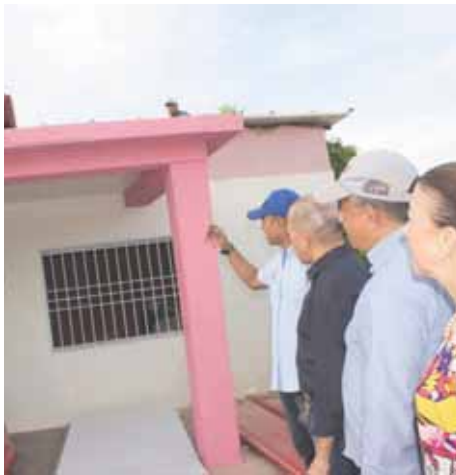
Recuperaron techos, fachadas, puertas y ventanas. Foto: Oipeez
